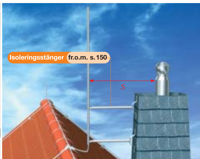
Korrekt upprätthållet skiljeavstånd s mellan uppfångare och skorsten i rostfritt stål
