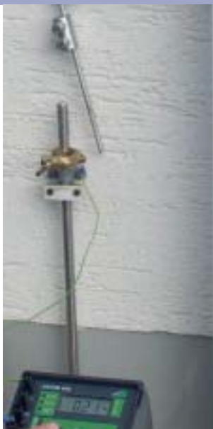
Mätning av avledningsresistans
